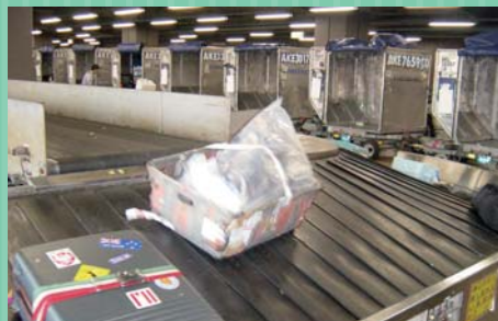
● 手荷物搬送設備
