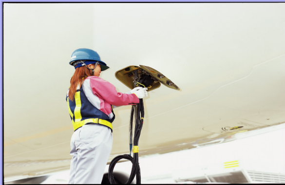
GPU (電力供給)
