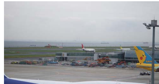
(羽田空港 南ピア増設工事)
